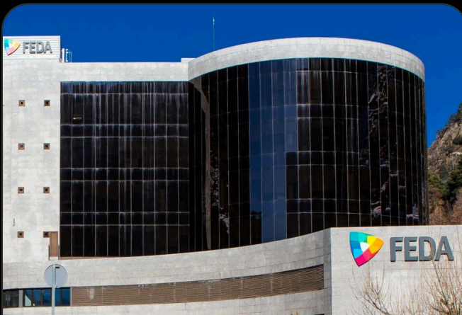
Un edificio de FEDA en Andorra. Foto del caso de éxito original.
