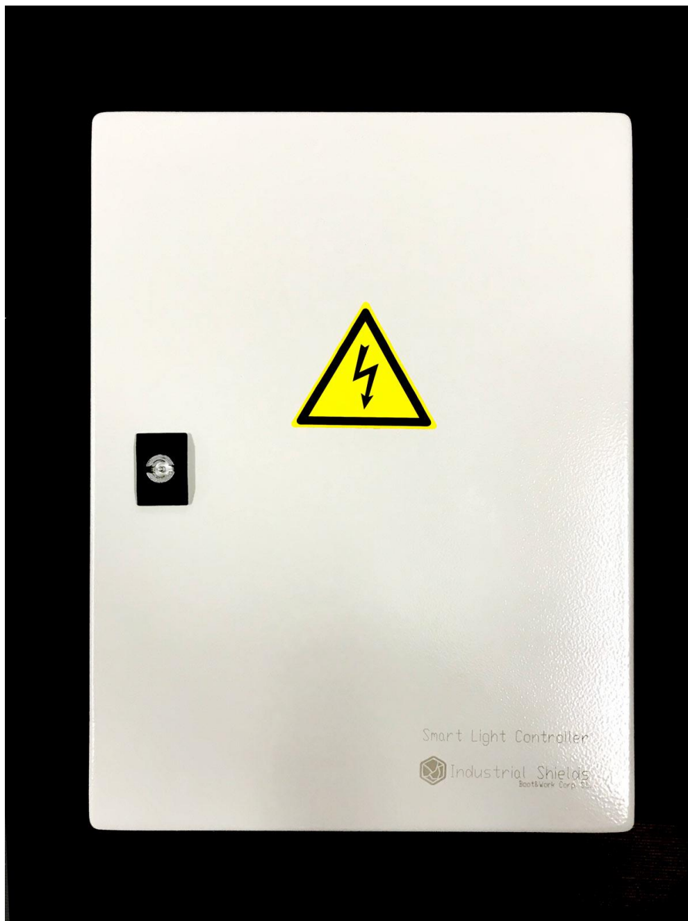
Fig 13.2. Parte frontal del cuadro eléctrico (cerrado)
